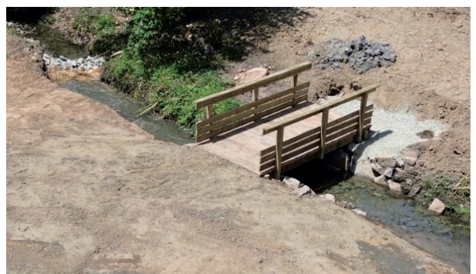
Vue aérienne du petit pont de bois.
